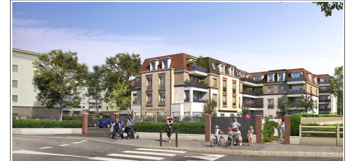
Bâtiment B1, Combles
